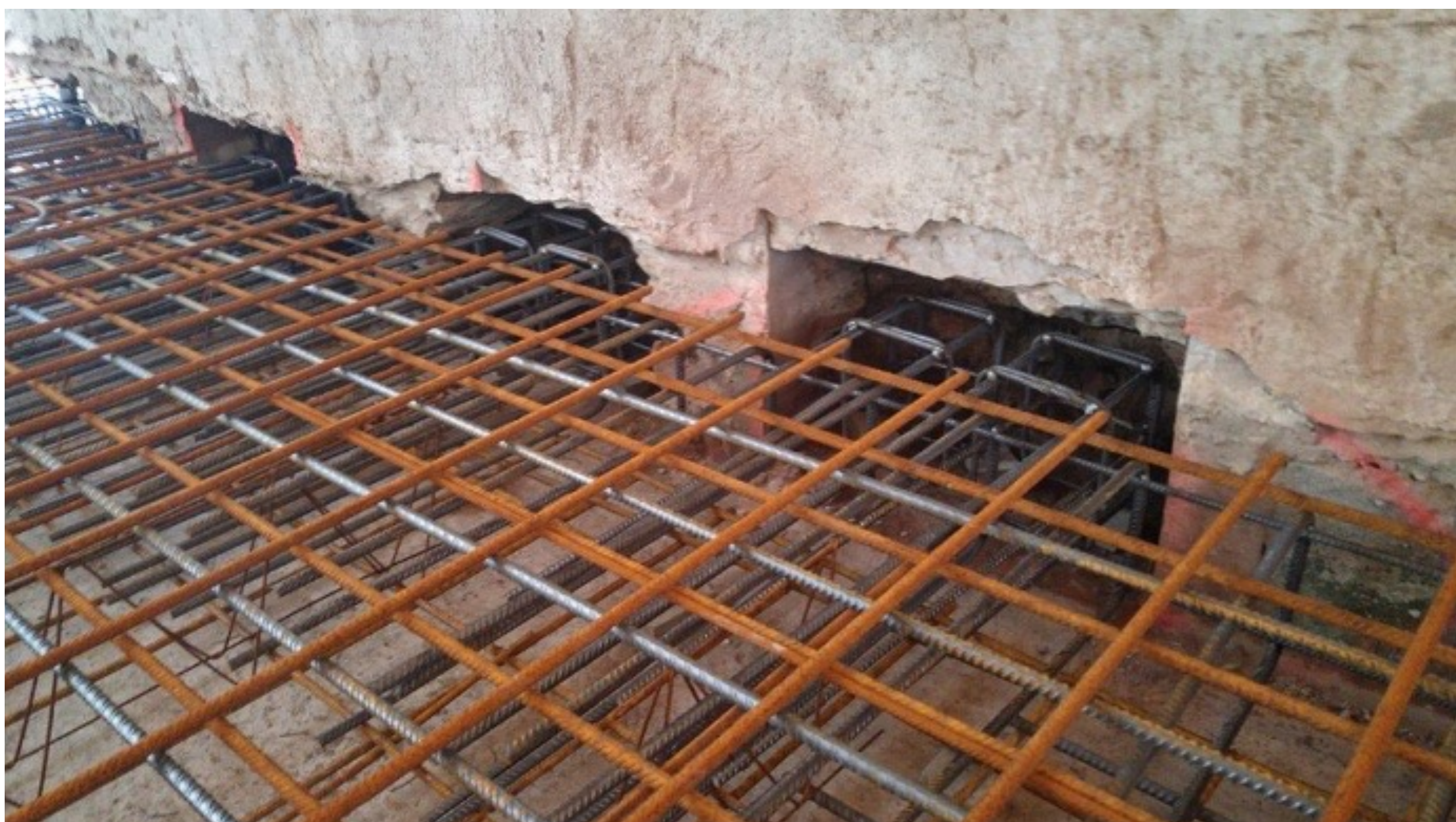
Voorbeeld inkassen bouwmuren
